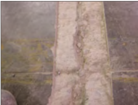
Preparazione di un travetto Set up of the joist
